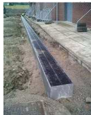
▲ 4. A beton törzs-szerkezet
