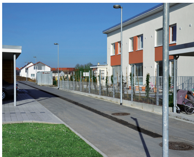
Regenwaterzuivering in de woonwijk Walldorf-Süd: al meer dan 10 jaar geen onderhoud nodig
