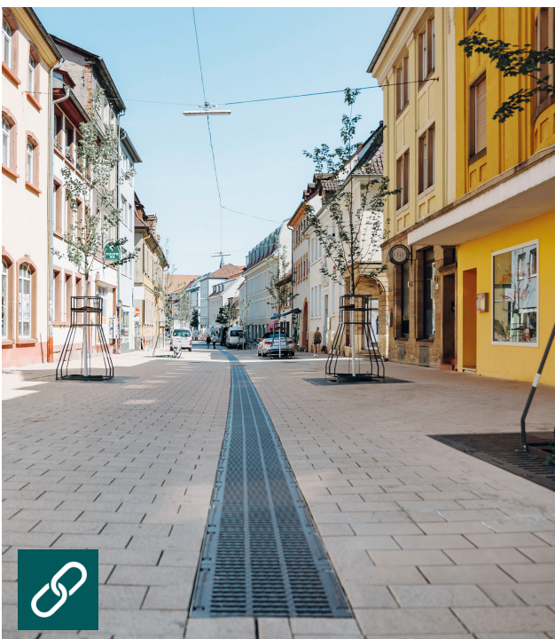
Landau, zuivering afstromend regenwater in de Königsstraße
