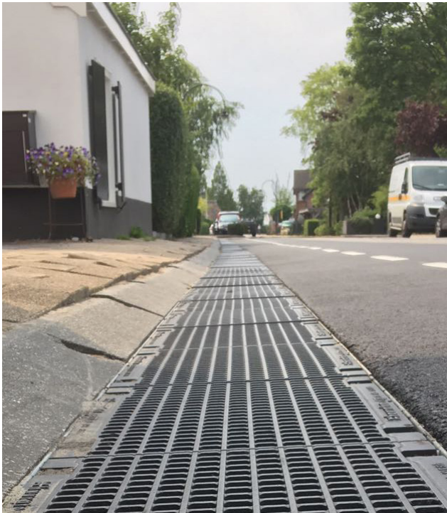
Loosdrecht, deelstroomzuivering richting Loosdrechtse Plassen
