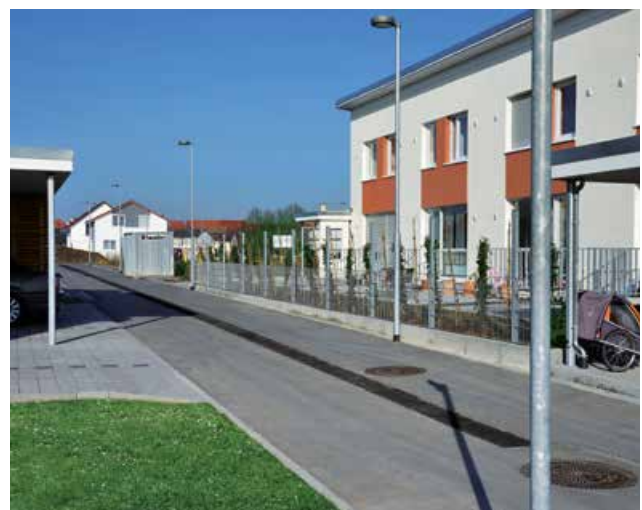
Regenwasserbehandlung im Wohngebiet Walldorf-Süd seit über 10 Jahren ohne Wartung.
