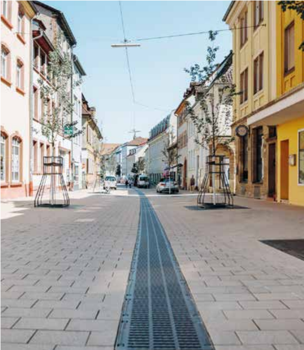
Landau, Sanierung der Königsstraße
