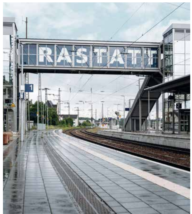
Rastatt, Sanierung Bahnhof
