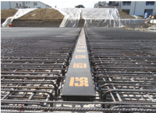
Rinnenstrang fertig montiert und vorbereitet zum Betonieren
