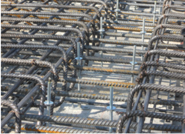
Montagevariante Rinneneinbau auf Montageset nach Verlegung der Bewehrung
