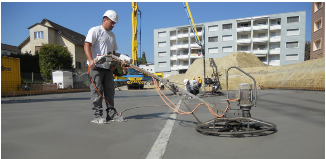
Betonieren, abtalschieren auf Oberkante Bretteinlage und längsseitiges Fasen an Zargenkante
