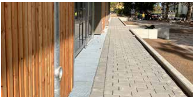
Um Holzfassaden zu schützen, müssen sie entwässert hinterlüftet werden. Die Spezialrinnen sorgen für die Entwässerung und für die Luftzirkulation hinter der Fassadenkonstruktion.
