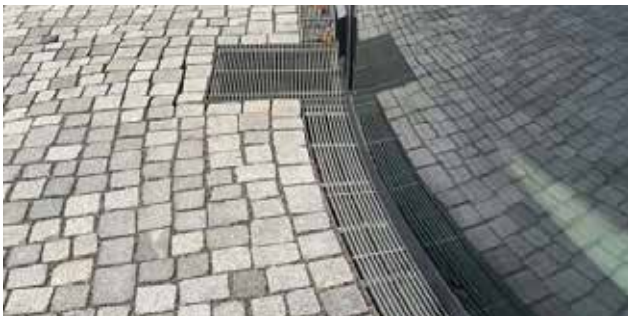
Barrierefreie Entwässerung eines Penthouses in Wiehl.
