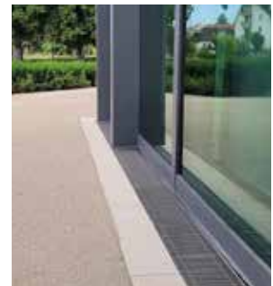
Die Abdeckung bietet gleichzeitig einen sicheren Spritzschutz.
