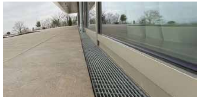
Normgerechte Entwässerung von unterbauten Bereichen.
