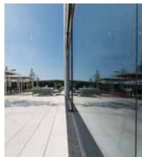
Glasfassaden verlangen nach eleganter Entwässerung, die auch einen Austausch von Glaselementen ermöglicht.
